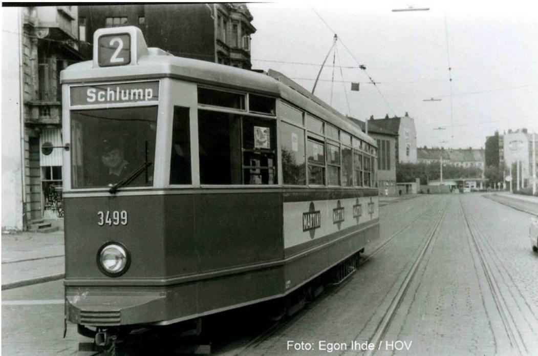
*Zwischen Niendorf und Schlump gab es Verstärkungsfahrten. Hier endet am 24.05.1958 der V7 3499 am Grindelberg / Beim Schlump. Im Straßenpflaster ist entlang des Gleisstrang der sogenannte Pflichtstreifen zu erkennen. In einem Vertrag von 1935 hatte sich die HHA gegenüber Hamburg verpflichtet, diesen Teil der Trasse in einer Straße auf eigene Kosten zu unterhalten, um dadurch die Verkehrssicherheit für andere Verkehrsteilnehmer zu gewährleisten.*
