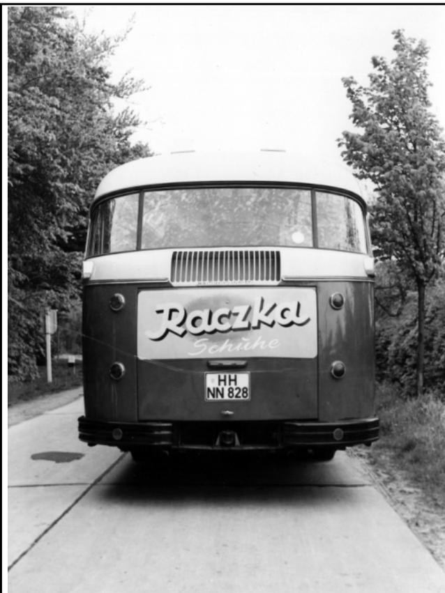
Heckansicht Saturn II Wagen 6802: Kleine Liniennummeranzeige hinter Heckscheibe, vereinte Brems- und Rückleuchten, Auspuffrohr an der Wagenunterkante.
